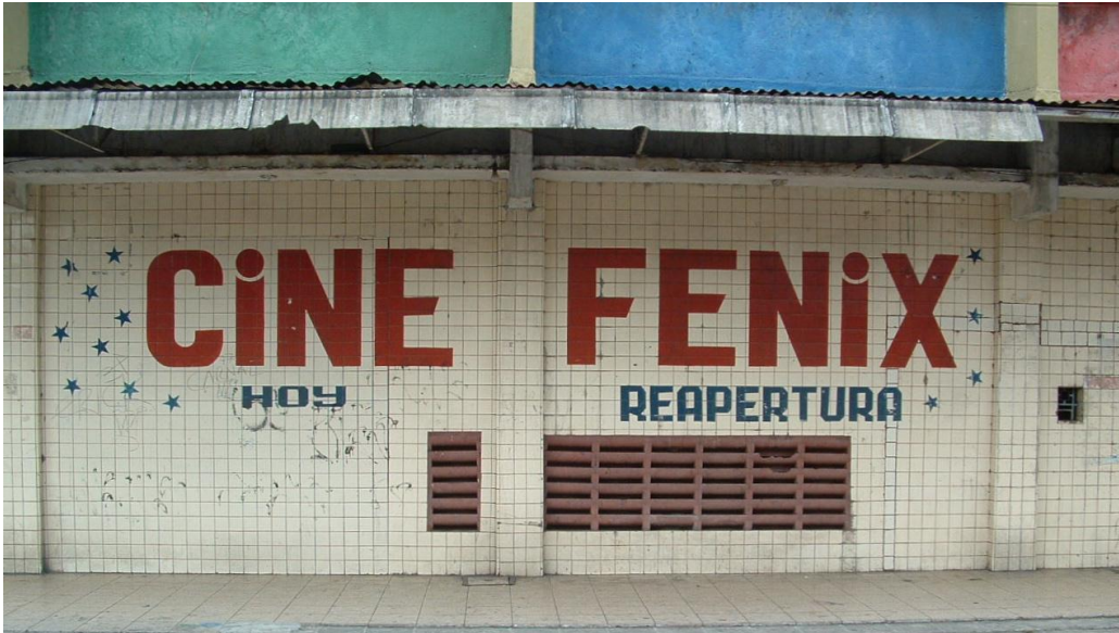
Figura 25. Fotografía de la fachada del Cine Fénix. 2008
